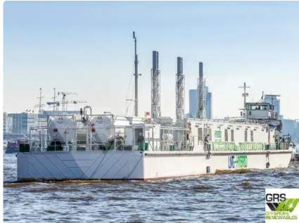
LNG POWER BARGE // 7,5 MW // 76m / 12,2m / #1123594
